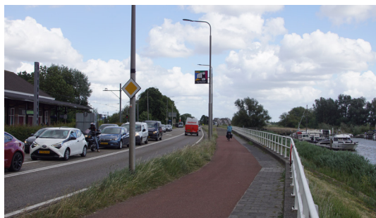
Foto van deeltraject 6.3 IJsselmuiden Station
